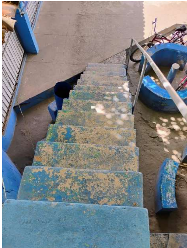
Foto 2 - Escada de acesso à sala de música
