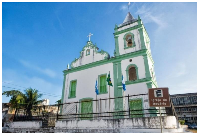
Figura 12: Igreja Nossa Senhora do Rosário dos Pretos vista de frente
