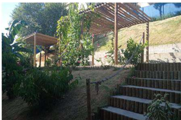
Figura 23 – Área de convivência pátio interno - EEEFM José Vitor Filho (I)
