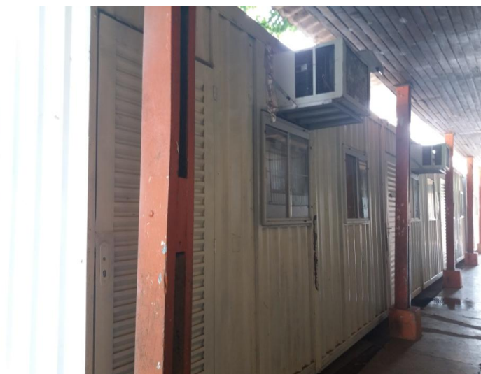
Figura 04: Salas anexas. Fonte: Arquivo da pesquisadora
