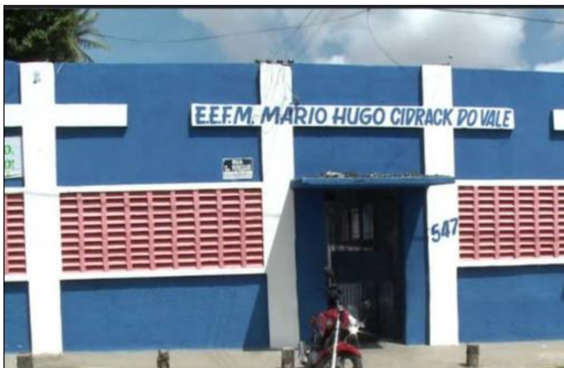
Figura 2 – Fachada da Escola de Ensino Fundamental e Médio Mario Hugo Cidrak.
