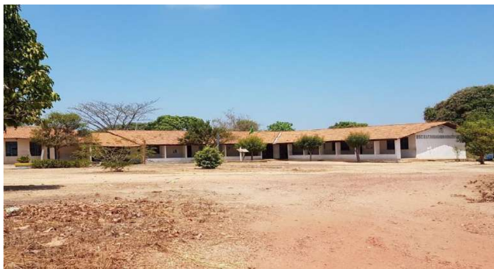
Imagem 1 – Área externa frontal da escola campo
