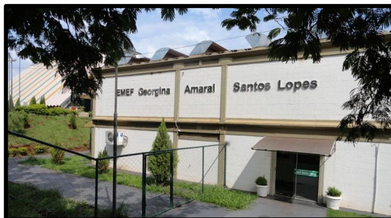
Figura 48 - Fachada da escola
