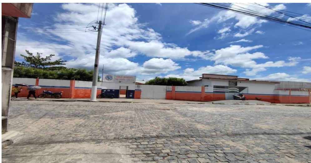
Figura 1 – Foto da fachada da EMPESantos
