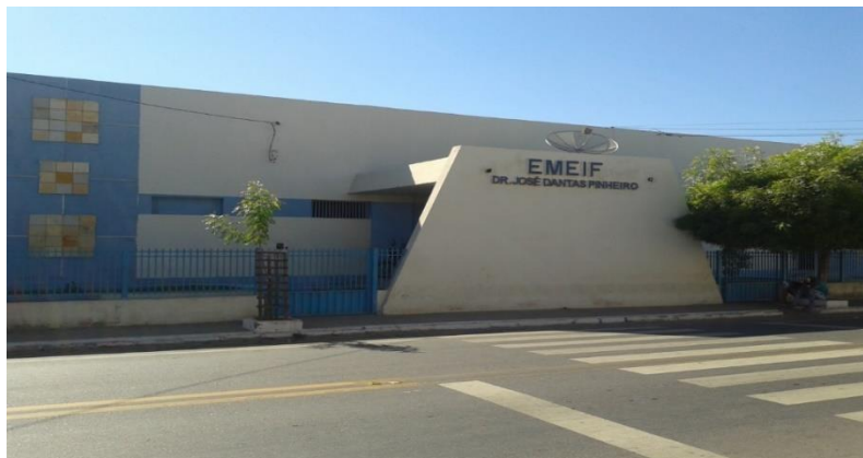
Figura 1: Fachada da Escola
