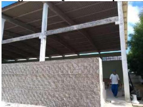
Imagem 19 – Quadra de esportes em reforma
