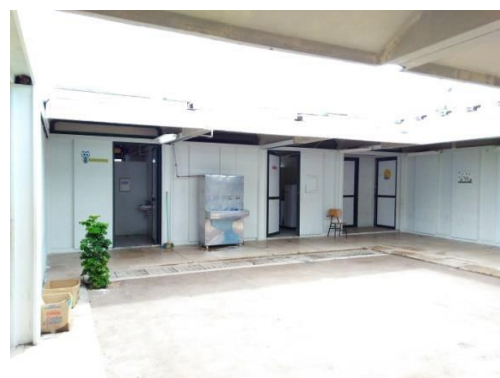
Ilustração 12 - Pequeno pátio, banheiro masculino, cozinha e salas de aula
