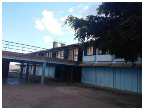
Ilustração 8 - Prédio principal, onde a escola funcionou até o ano de 2017
