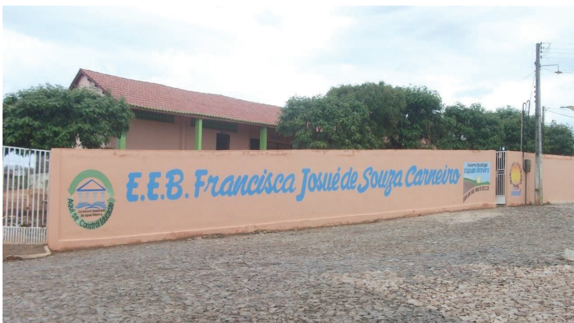
Foto 1- Fachada da escola
