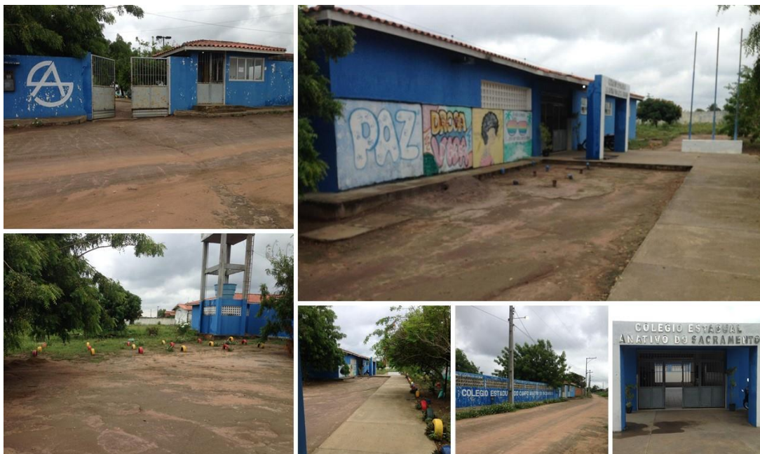
Imagem 02 – Prédio onde funciona a Escola Municipal do Murici
