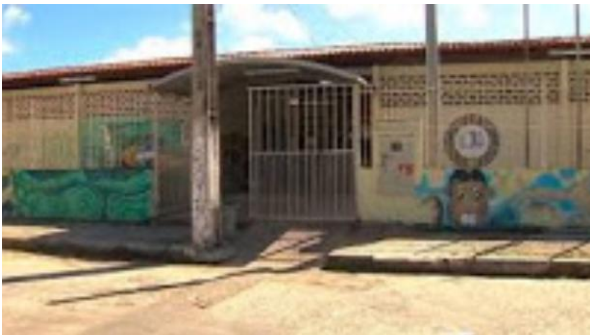
Figura 1: Entrada da EEJAC
