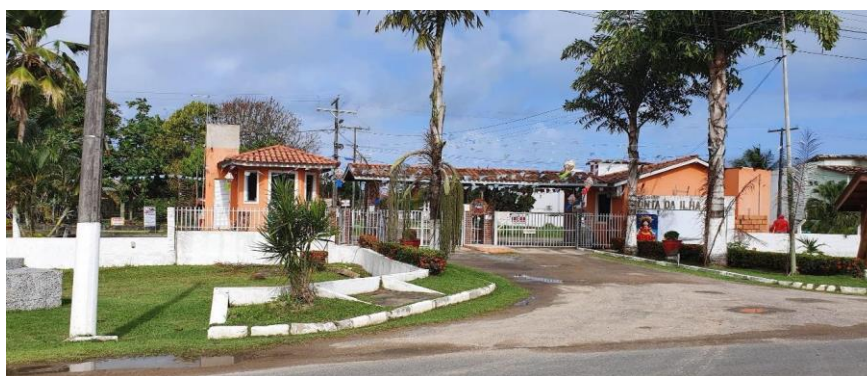
Figura 3 - Condomínio Ponta da Ilha, um dos vários existentes à margem esquerda da entrada de Cacha-Pregos
