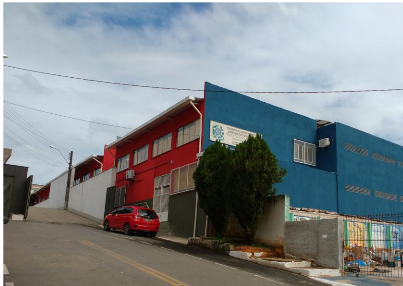
Foto 6 - Fachada da Escola
