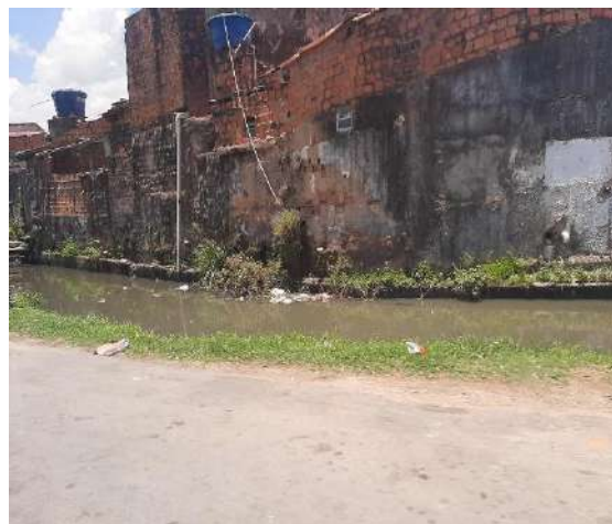
FIGURA 10: Esgoto a céu aberto
