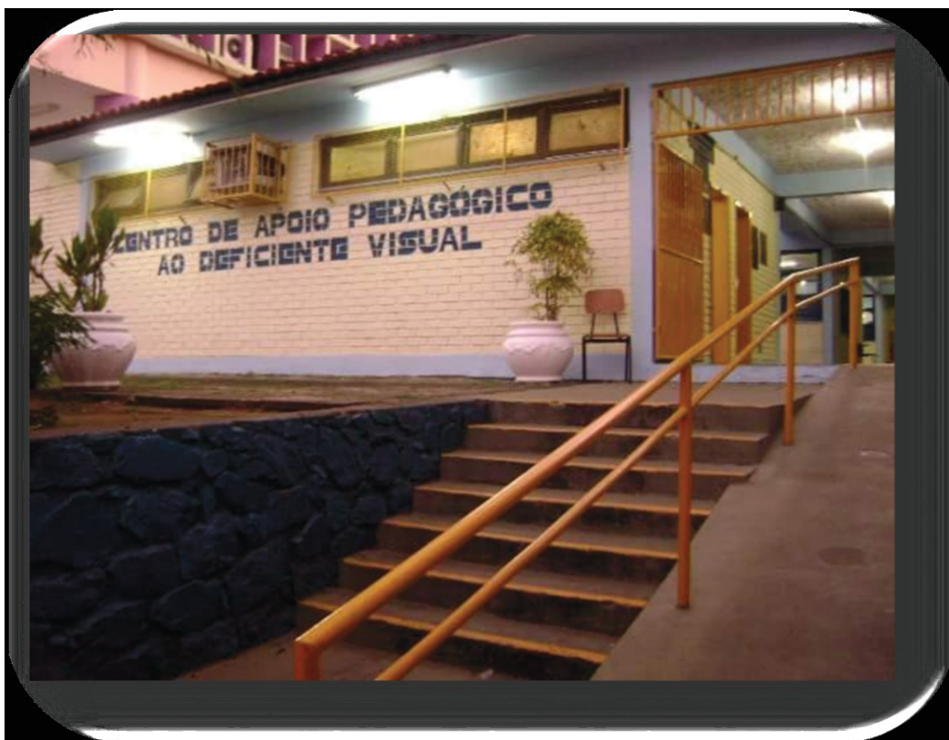
Figura 10 - Fachada do CAP.
