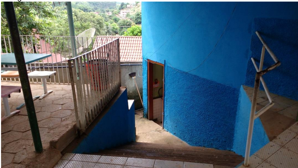
Fotografia 5 - Acesso à biblioteca da escola.
