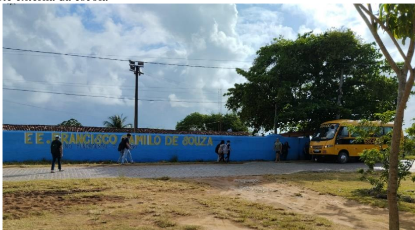
Figura 1 – Parte externa da escola
