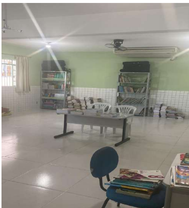
Figura 3 — Biblioteca da Unidade de Ensino em processo de reforma
