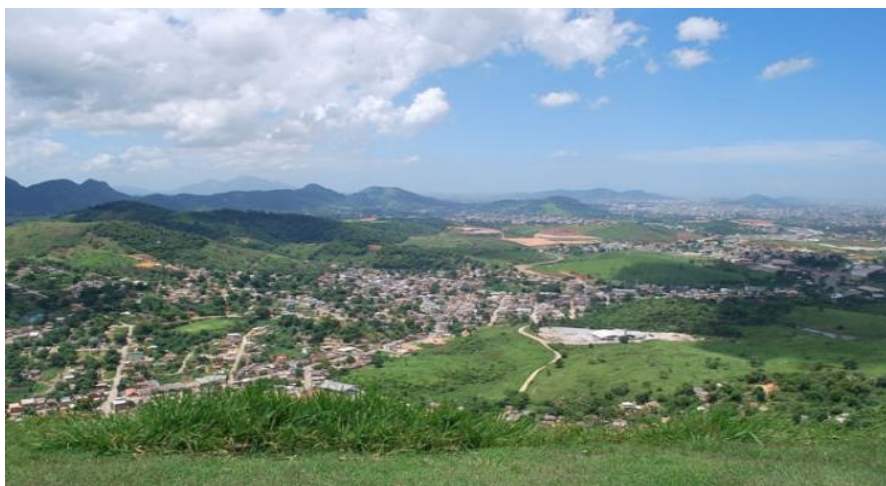
Figura 2 – Vista do bairro onde está localizada a escola
