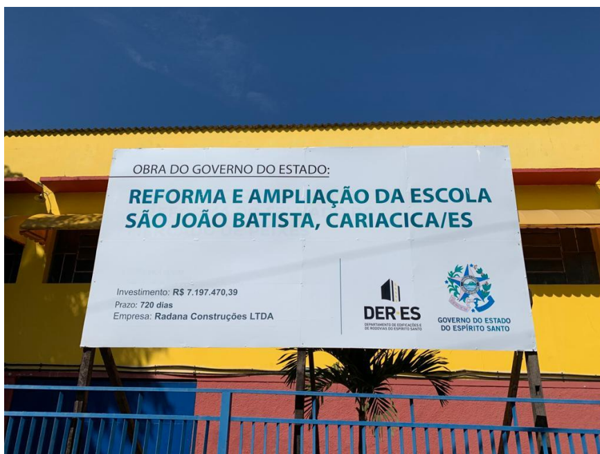
Figura 9 – Placa informativa de reforma da escola
